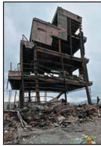
輪島朝市火災現場
